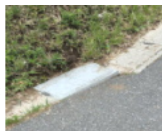
雨水溝の修繕 (前ヶ崎2-24付近)
