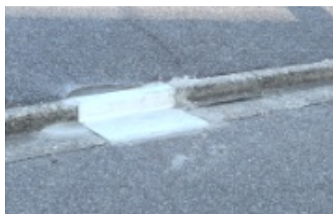
駐車場の修繕 (向小金1丁目)
