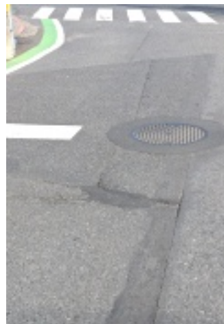
駐車場の修繕 (前ヶ崎634付近)
