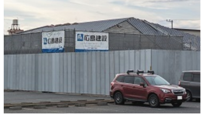
建設中の“白みりんミュージアム” 建設費7億円+年運用5000万円 (建設費が1.6倍に…)
