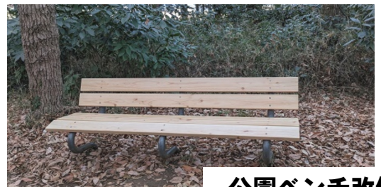
公園ベンチ改修 (松ヶ丘・散策の森)
