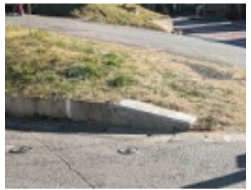
縁石の補修 (東部中学校入口)
