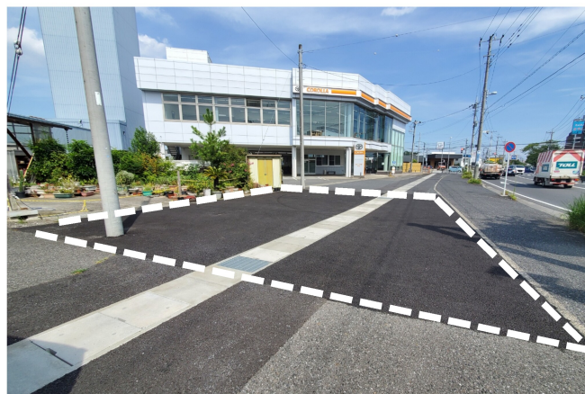
南流山の県道歩道部分（点線囲み）の舗装は、砂利からアスファルトに改善されました。
