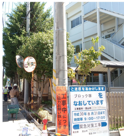
北部中学校ブロック塀の緊急改修工事
