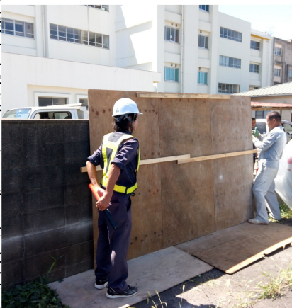
東深井小学校ブロック塀の緊急改修工事
