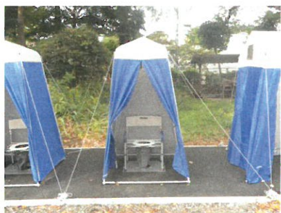
マンホールトイレユニット (災害時)
