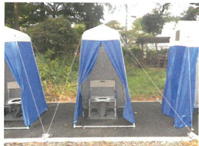
マンホールトイレユニット (災害時)
