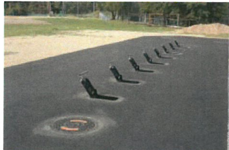
マンホールトイレユニット (平常時)
