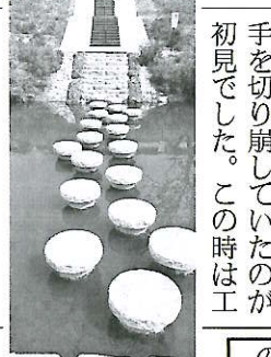
完成した飛び石 手すりがない
