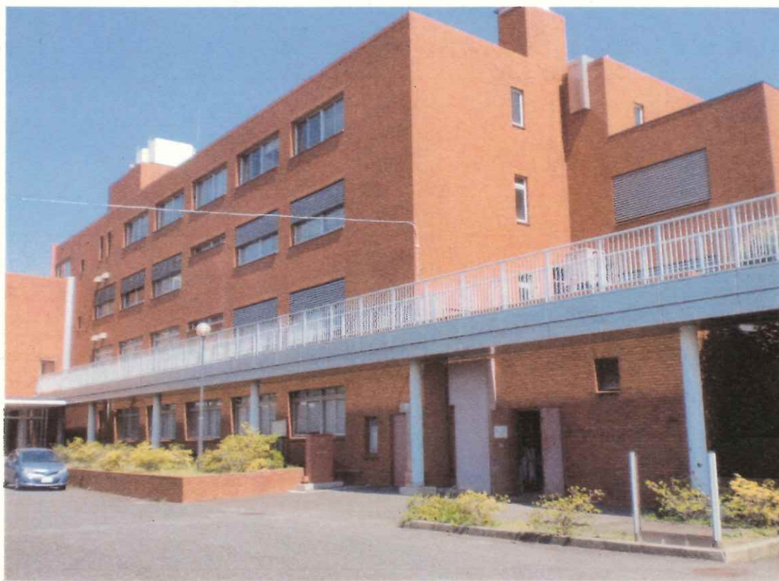
①. 1号館の北西側外観
