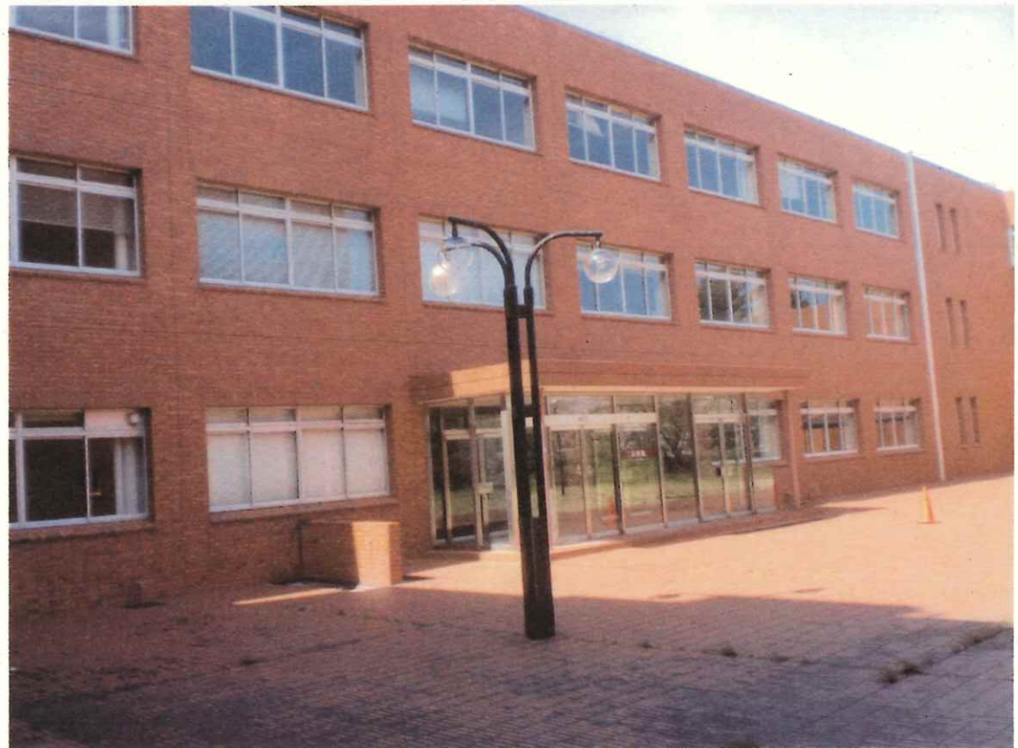
④. 2号館の南東側外観
