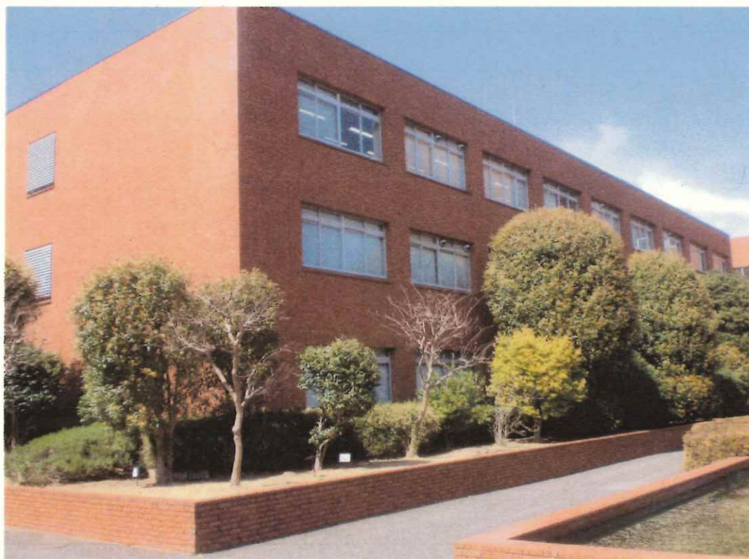
②. 1号館の南東側外観
