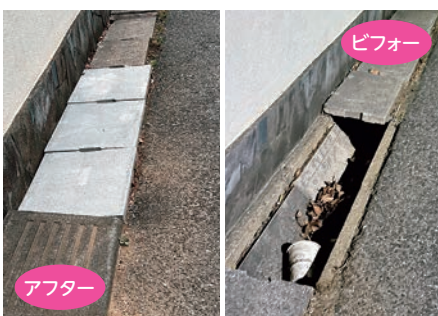
側溝の清掃とフタ修繕 (三輪野山2丁目)
