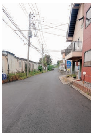
道路整備・舗装（前ヶ崎370地先） 高橋あきら
