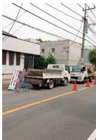
緊急の道路補修 (江戸川台東1丁目) 植田和子
