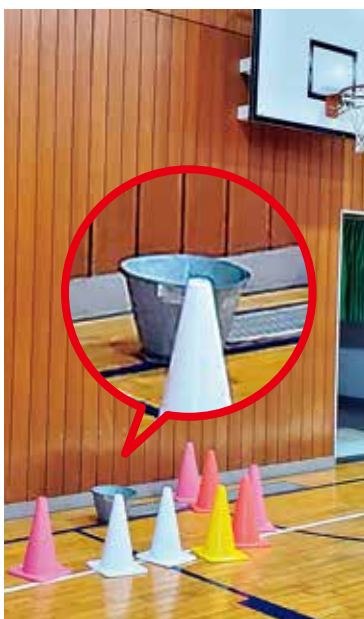
西初石中学校の体育館では、雨漏りが…。応急工事が実現しました。
