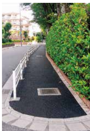
凹凸の歩道を修繕 (向小金1丁目パークハウス前) 高橋あきら
