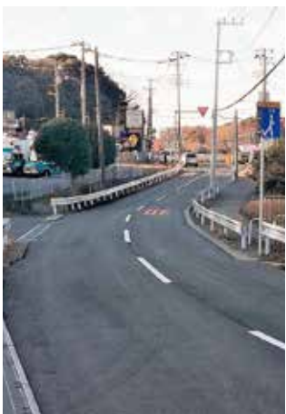
木谷工業前市道の道路補修 (名都借) 高橋あきら
