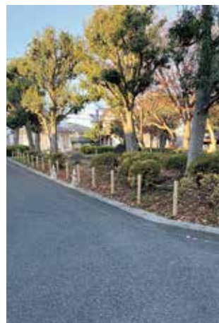
公園の古びて危険な鉄柵を撤去 (三輪山二丁目) いぬい紳一郎
