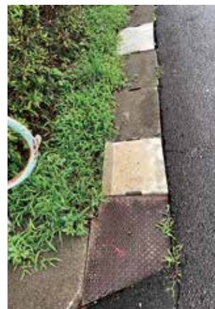
公園側溝の壊れていたふたを 補修 (三輪野山) いぬい紳一郎
