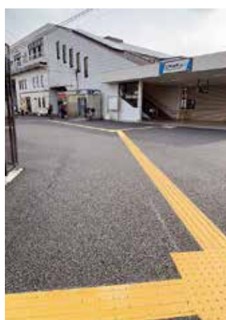
念願の歩道の路面 全面改修 （江戸川台駅東口） 植田和子
