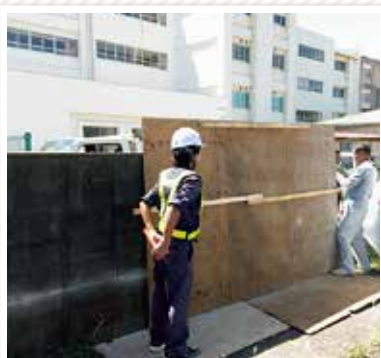
東深井小学校の危険なコンクリート塀を緊急撤去する地元事業者
