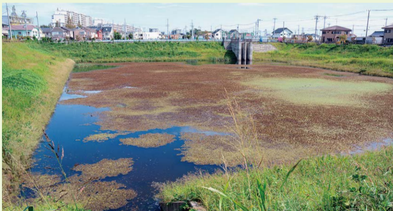
学校建設が予定された木地区の調整池
