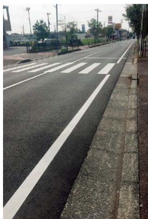
傷んだ道路を再舗装 (流山9丁目) いぬい紳一郎
