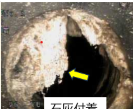
破損、浸入水
